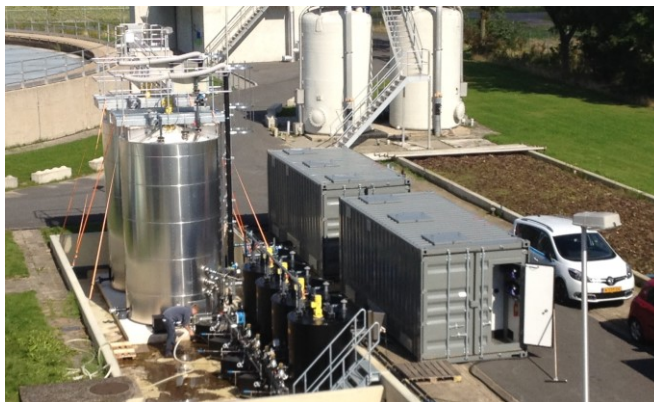
De pilotinstallatie op de AWZI Tollebeek
