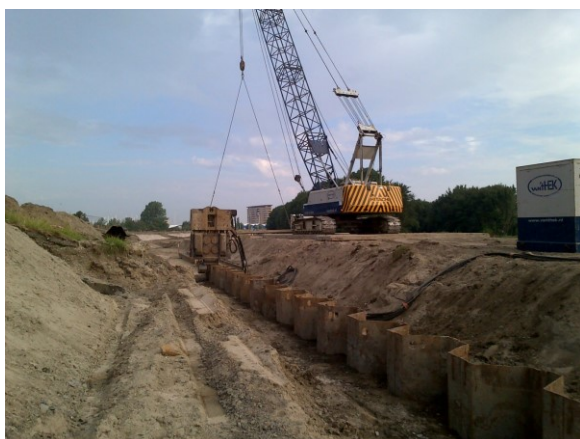
Het aanbrengen van de damwand waar achter gebouwd zal worden
